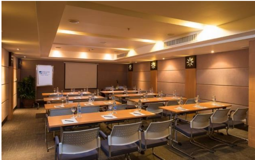
ภาพที่ 1 การติดตั้งดวงโคมภายในห้องประชุมที่ให้ความสว่างแบบกระจายความเข้มแสง ที่มา: www.lumencraftlighting.com
