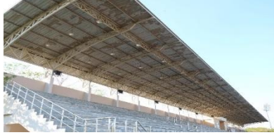
อาคารอ้อมจันทร์
