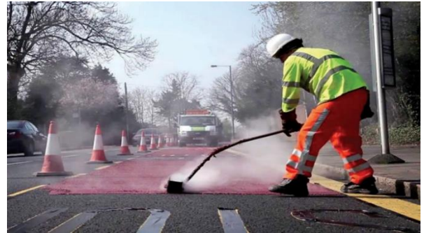
รูปที่ 1 การฉาบเคลือบเพิ่มแรงเสียดทานให้พื้นผิวทาง [10]
