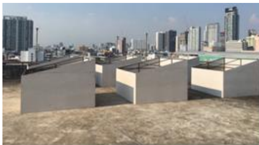
รูปที่ 4 กล่องทดสอบที่ดำเนินการสร้างเสร็จแล้ว
