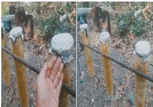
ภาพที่ 2.11 ติดตั้งสายไฟ 1 เส้น ต่อพลุ 3 ลูก
