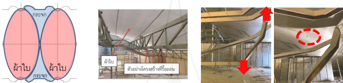
3a) โครงสร้างหลังคาผ้าใบ 3b) โครงสร้างหลังคาเหล็ก 3c) การฉีกขาดของโครงสร้างหลังคาผ้าใบ
