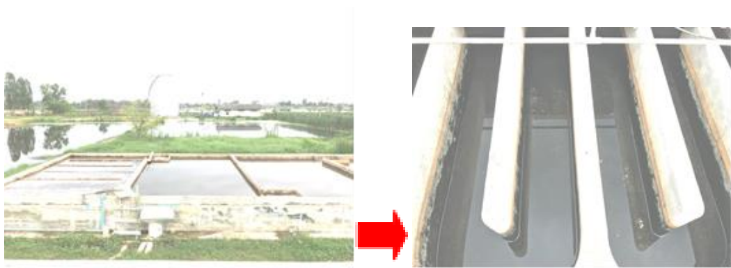
รูปที่ 8 การส่งน้ำจากบ่อซีเมนต์ไต่ระดับไปยังบ่อวนตักการชะลอน้ำและเก็บสารแขวนลอย
