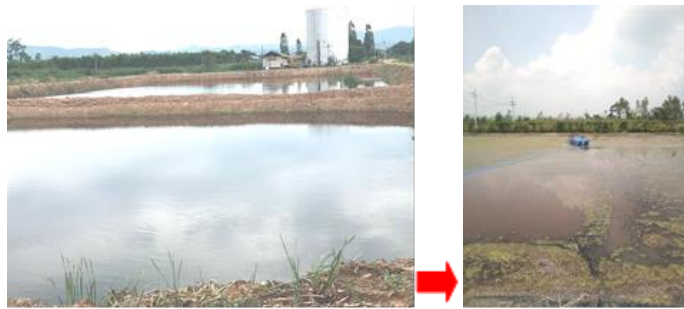
รูปที่ 6 การส่งน้ำจากบ่อบำบัดน้ำเสียบ่อสุดท้ายไปยังบ่อเตรียมสำหรับกระบวนการเติมสารเคมี
