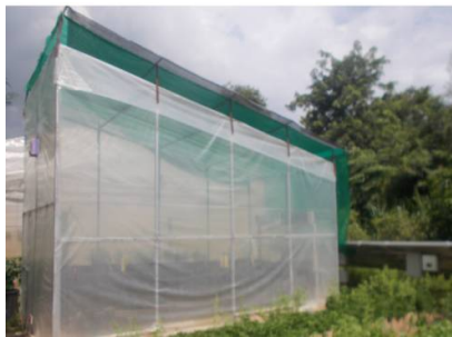
(ก)โรงเรือนปลูกผักระบบปรับอากาศฯ
