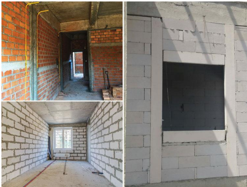
รูปที่ 4 รูปการก่อสร้างผนังโดยใช้อิฐมอญ กับ อิฐมวลเบา และการทำคานทับหลัง
