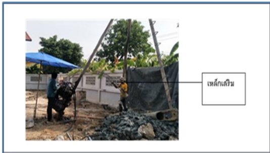
ภาพที่ 2.3 การนำเหล็กเสริมคอนกรีต ลงหลุมเจาะ
